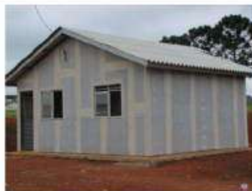
Figura 2 – Fechamento da face externa dos quadros estruturais com placas cimentícias em uma unidade habitacional térrea
