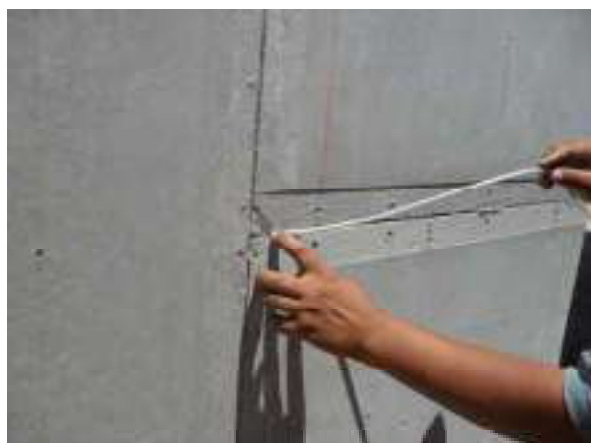
Figura 19: Introdução do cordão de polietileno
