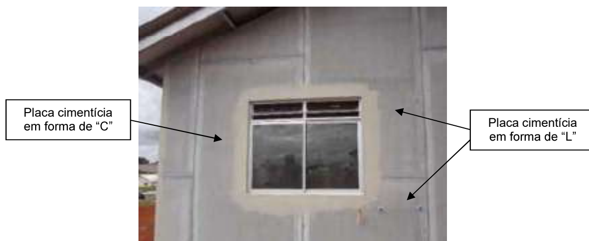
Figura 5 - Paginação das placas cimentícias e aberturas
