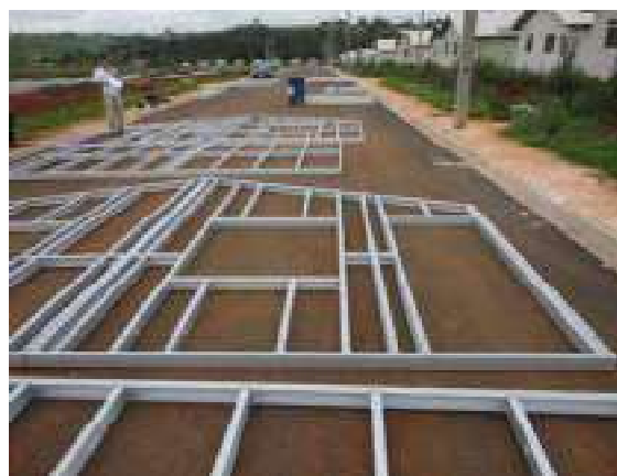
Figura 14: Montagem dos quadros estruturais fora do seu local definitivo
