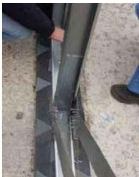
Figura 15: Fixação dos quadros estruturais à fundação
