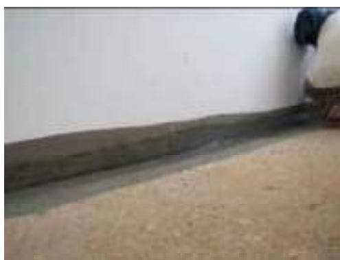
Figura 23: Impermeabilização da base da parede da cozinha
