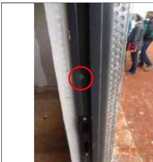
Figura 17: Parafuso de fixação das esquadrias
