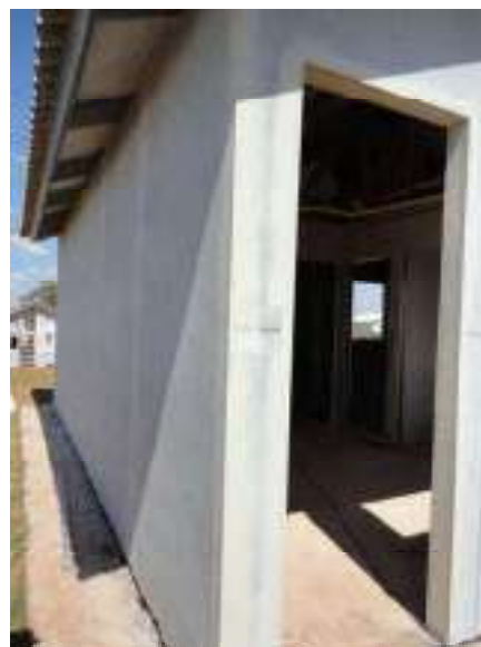
Figura 16: Fechamento da face externa dos quadros estruturais com placa cimentícia e requadro de vão com acabamento em placas cimentícias
