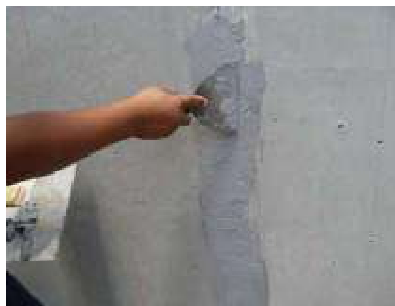
Figura 20: Preenchimento das juntas com massa.
